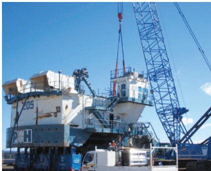
► Zvedání zařízení v důlním průmyslu
